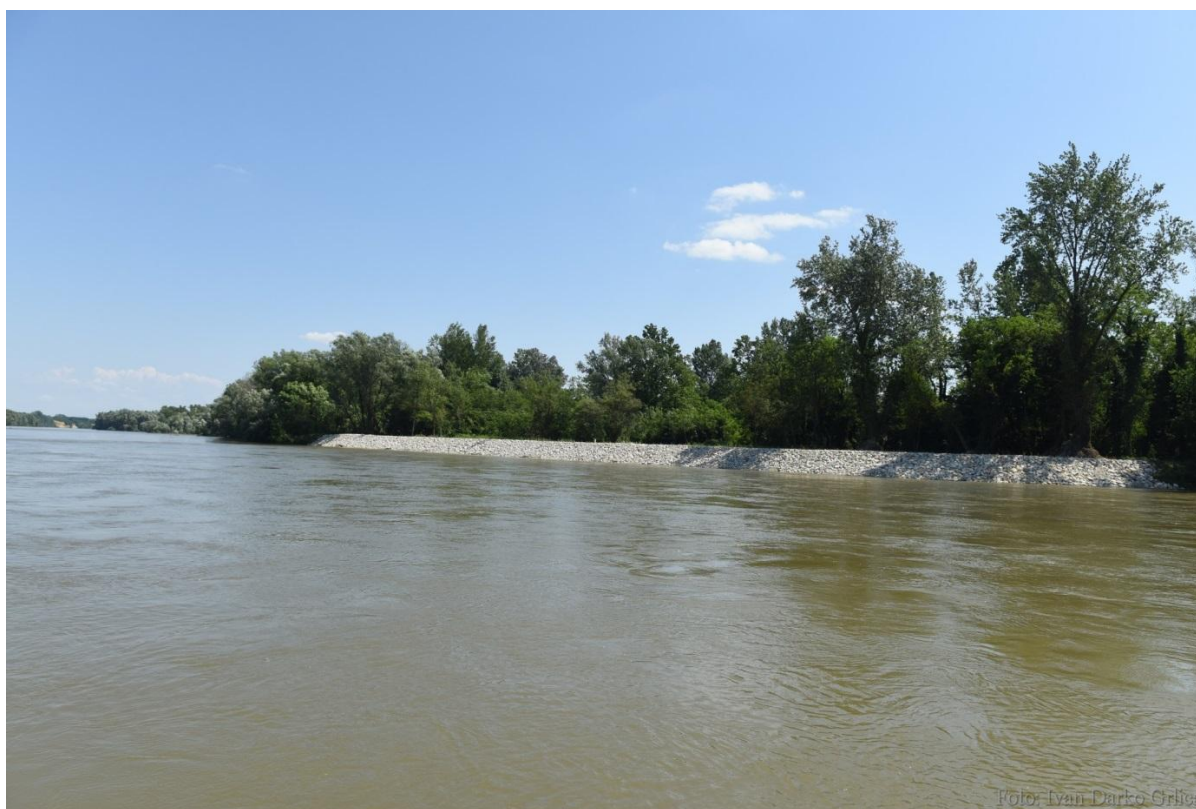
Sl. 43. Izgradnjom vodnih građevina trajno se zaustavlja bočna erozija te nestaje mogućnost stvaranja tipičnog riječnog staništa „Strme obale“ što direktno ugrožava opstanak vodomara i bregunica, 191 rkm (11.06.2022).
