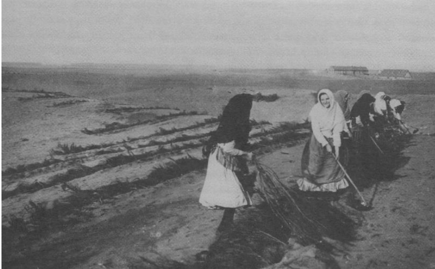
Slika 7. Radovi na smirivanju pijesaka početkom 20. stoljeća – u iskopane brazde polagale su se sadnice grmlja i drveća. Izvor: Petrić, 2008.
